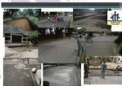
CONSTRUCCIÓN DE LA AVENIDA JAMUNDÍ-VALLE ORIENTAL
